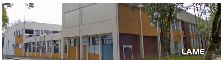
Laboratório de Materiais e Estruturas
